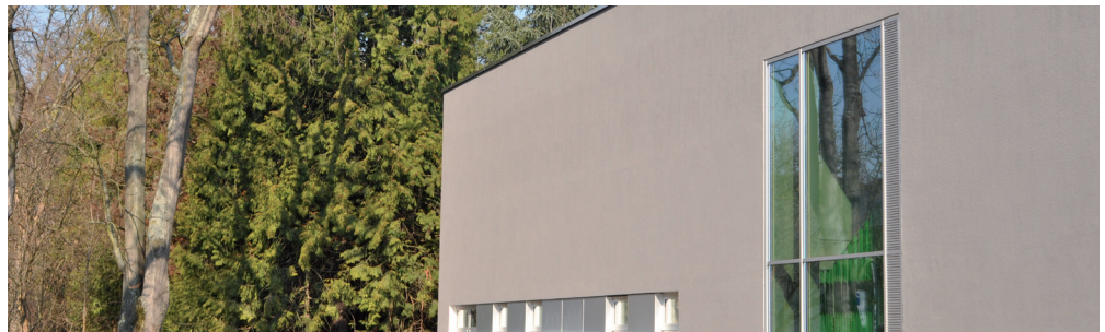
2016: Übergabe des neues Verwaltungsgebäude (BoGa-Zentrum). Foto: U. Wagenfeld.
